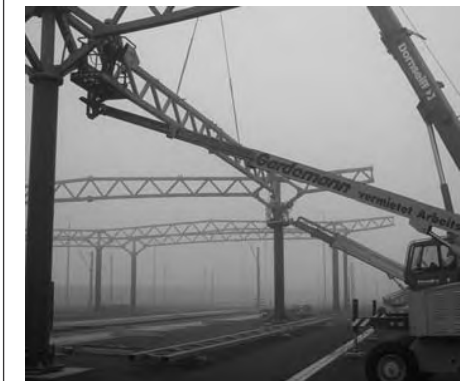
Sl. 9: Sastavljanje komponenti na tlu i postavljanje pomoću platforme za rad na visini
