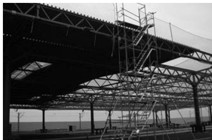
Figura 13: Torre aislada de escaleras de pedestal
