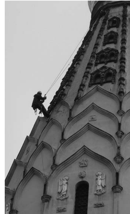
Figura 7: Métodos de trabajo y de acceso con ayuda de cuerdas
