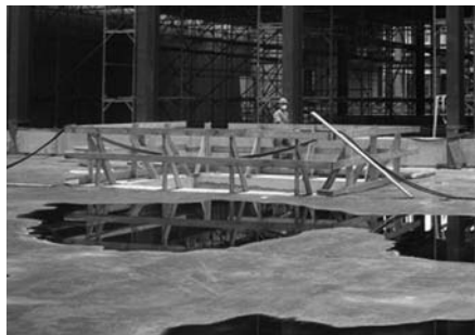
Figura 6: Bordos de excavaciones y declives
