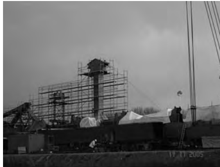
Bild 4: Arbeits- und Schutzgerüste
