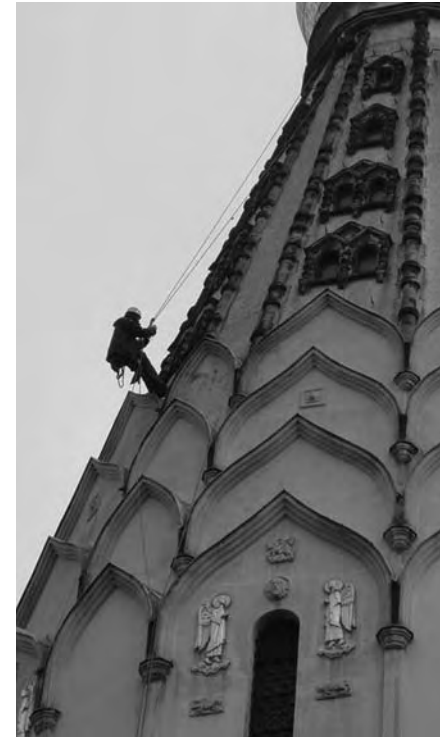
Bild 7: Seilunterstützte Arbeits- und Zugangsverfahren
