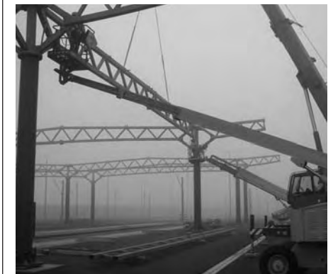
Bild 9: Vormontage zu ebener Erde und Montage mit einer fahrbaren Hubarbeitsbühne
