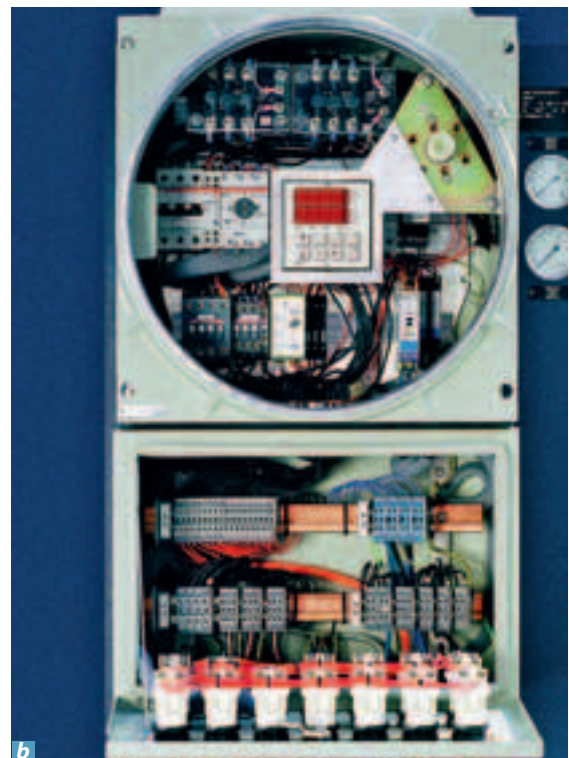
Bild 7 Beispiel wie wirksame Zündquellen unwirksam gemacht werden können: Explosionsgeschützter Schaltschrank, Zündschutzart «druckfest gekapselt» mit Klemmenkasten in Zündschutzart «erhöhte Sicherheit» a) geschlossener Schaltschrank b) geöffneter Schaltschrank
