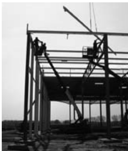
Obr. 5: Pracovní podlahy ve výšce
