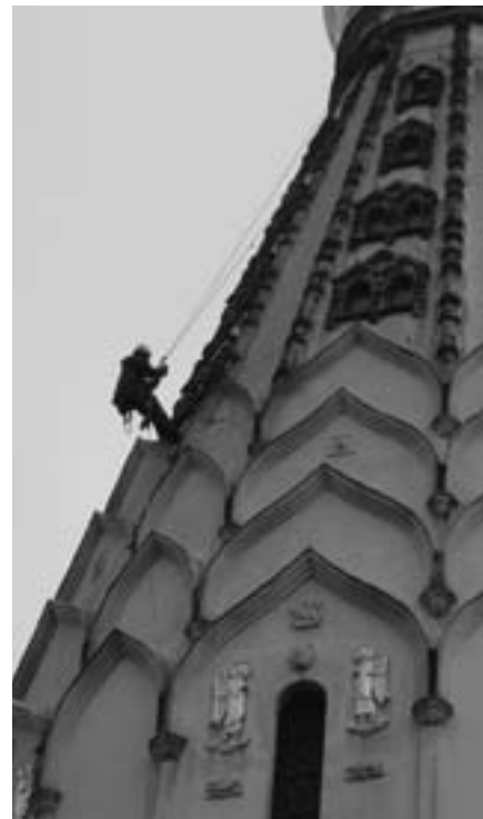
Obr. 7: Výškové práce s využitím lan
