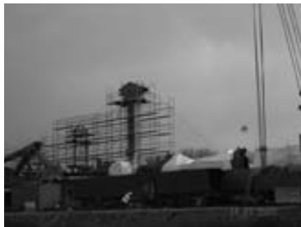
Obr. 4: Pracovní a zabezpečovací konstrukce
