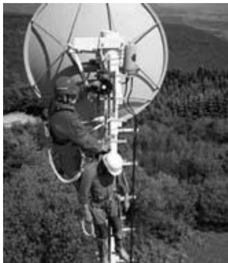
Obr. 19: Příklad záchrany zavěšené osoby
