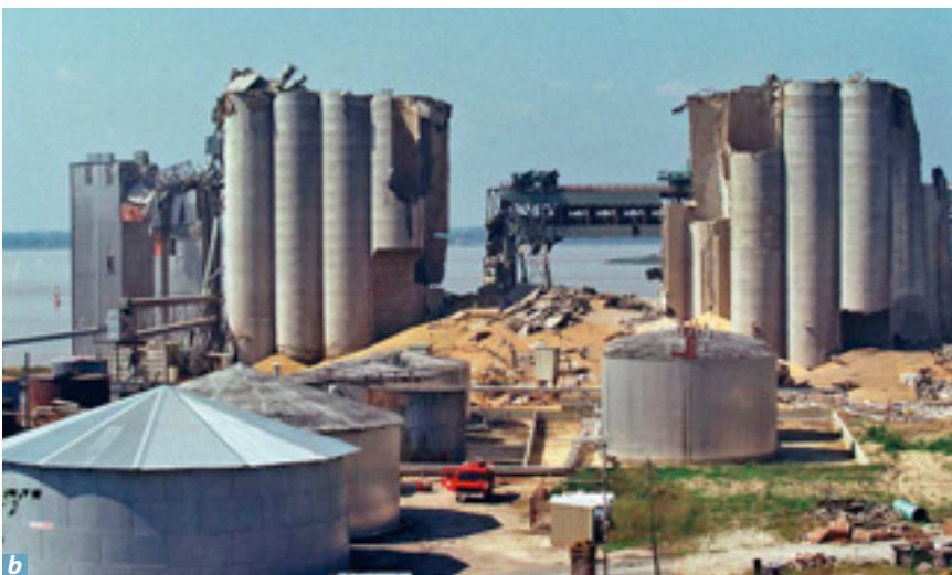
Figure 1 Effets des explosions: a) conséquences d'une explosion de gaz dans une centrale électrique b) effets d'une explosion de poussières dans un silo à grains: la majeure partie des 44 cellules du silo ont été totalement détruites
