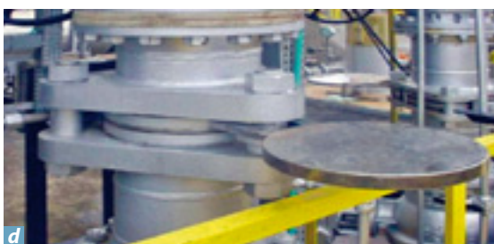
Figure 30 Exemples de mesures applicables pour la maintenance : a) permis de feu b) détecteur avertisseur de gaz pour la protection des personnes c) contrôle d'ambiance en vue de déterminer si l'atmosphère est explosive d) dispositif de séparation-obturation type queue de poêle (élément permettant de consigner une canalisation) e) contrôle des mesures de protection dans les zones à risque d'explosion
