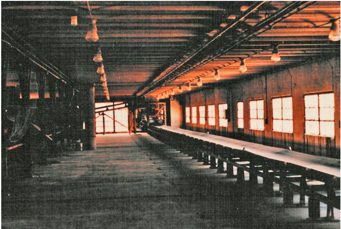
Bild 40: Siloboden mit Förderband und splitterfreien Fensterelementen als Druckentlastung (Prof. Siegfried Radandt)
