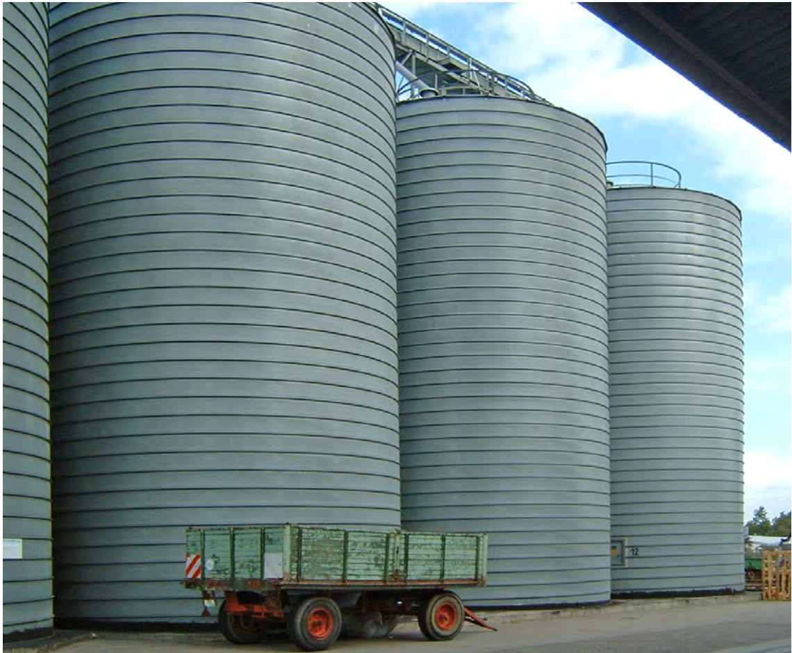
Bild 17: Flachbodensilos mit integrierten Ausräumschnecken (Prof. Siegfried Radandt)
