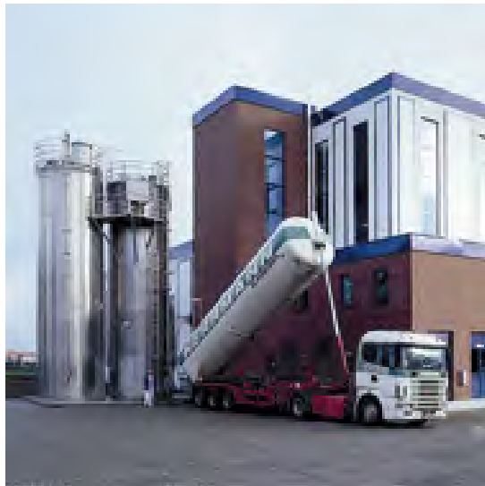
Bild 13: Silofahrzeug in Kippstellung zur Befüllung der Lagersilos. (AZO GmbH + Co. KG)
