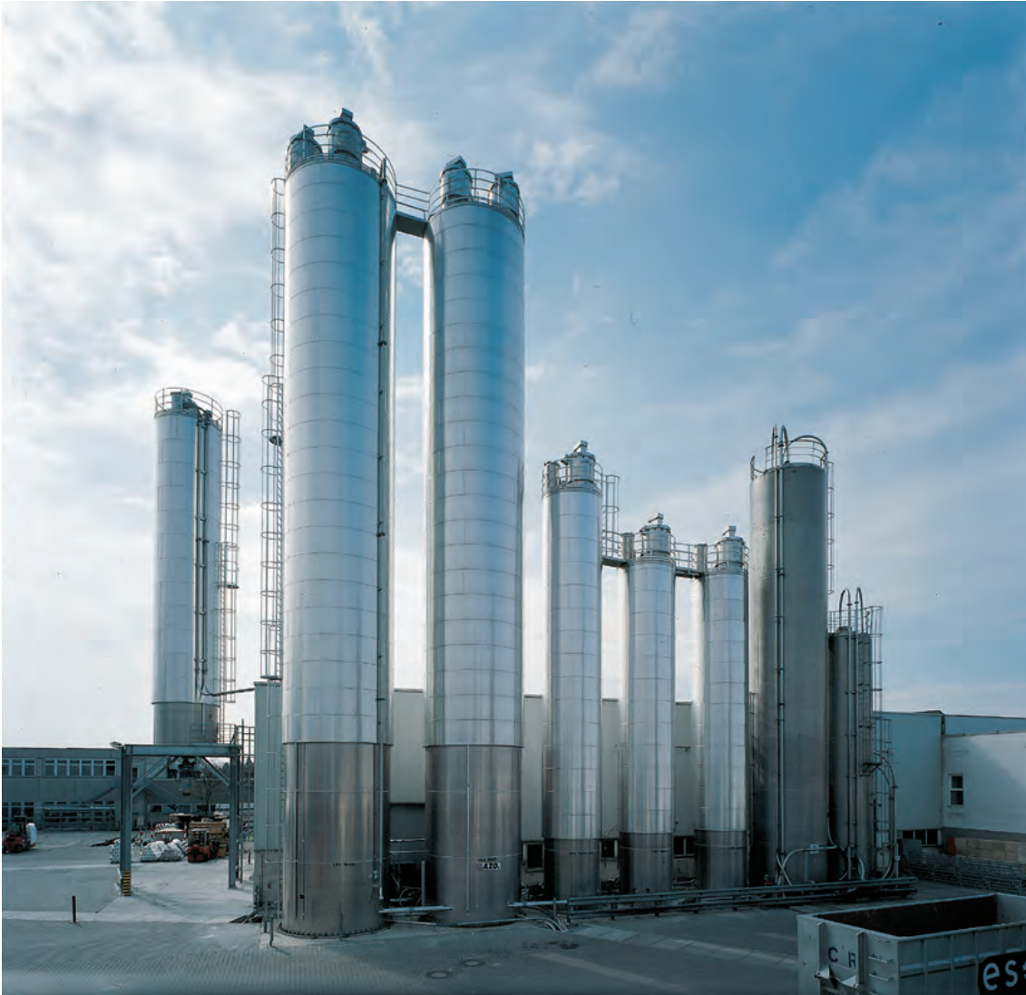
Bild 1: Siloanlage mit Außensilos (AZO GmbH + Co. KG)
